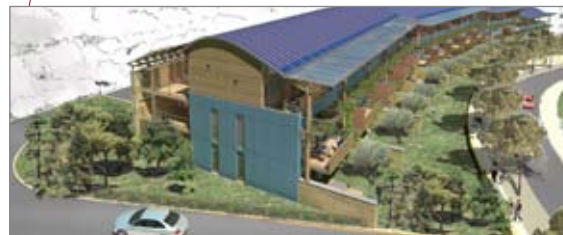
Bâtiment résidentiel « bas carbone » à Villeneuve-lez-Avignon
